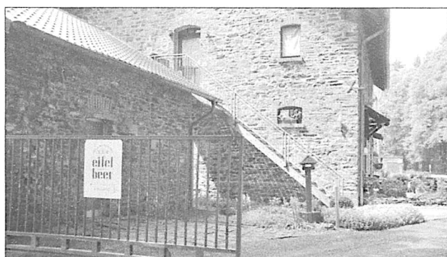
Im Erdgeschoss der Domäne sind die Produktionsräume zu finden, auf der 1. Etage moderne Räumlichkeiten für Verkostungen.
